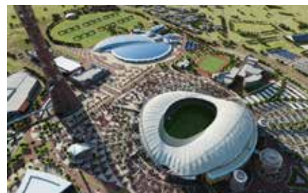
Stadion Khalifa International (40.000 locuri)
